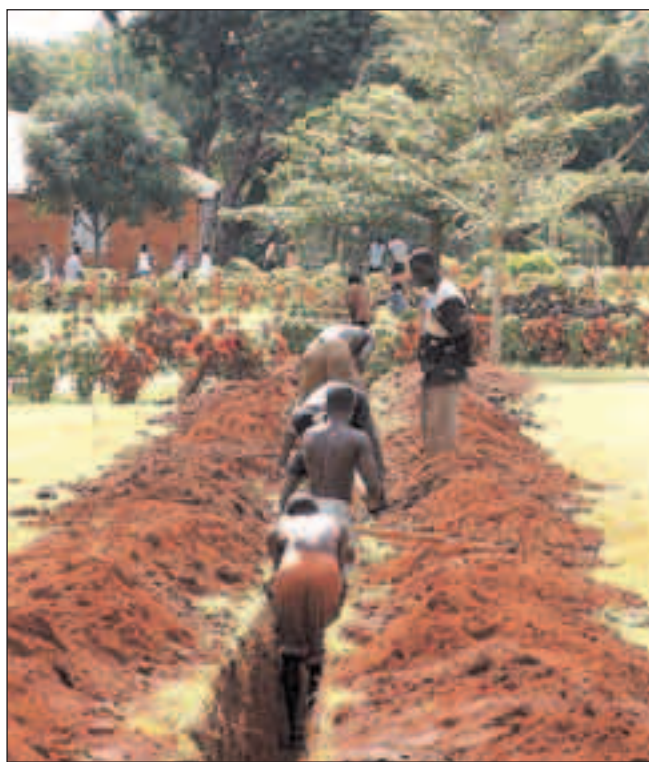
30 fanger fra det lokale fængsel sørgede for nedgravning af kabler. Lønnen var 2 kr. pr. dag, varm mad på universitetet og mulighed for at blive løsladt før tid.
